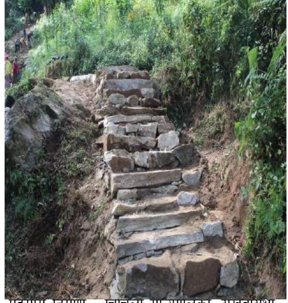
पदमार्ग निर्माण - चिचिला गाउँपालिका, संखुवासभा
