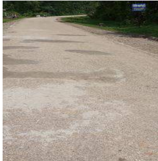
बाटो निर्माण तथा मर्मत-हुप्सेकोट गाउँपालिका, नवलपरासी पूर्व
