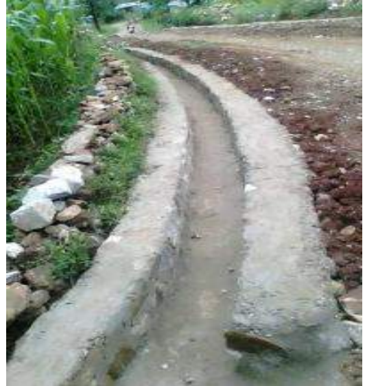
पक्की नाला निर्माण-गण्डकी गाउँपालिका, गोरखा
