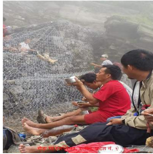
सडक तार जाली निर्माण-रोड गाउँपालिका-६, इलाम
