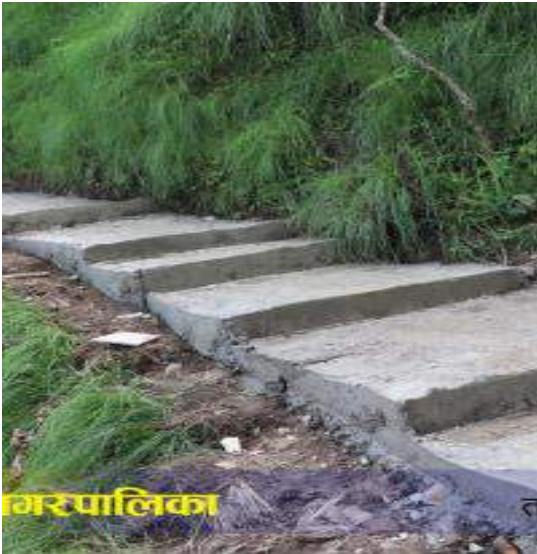
पदमार्ग निर्माण-भीरकोट नगरपालिका-६, स्याङ्जा
