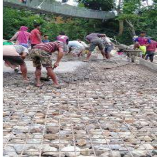
सडक सोलिड-तीनपाटन गाउँपालिका, सिन्धुली
