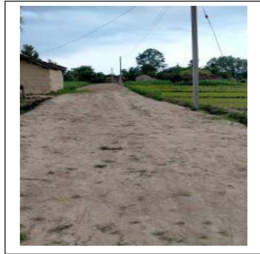
सडक निर्माण तथा स्तरोन्नती-लालझाडी गाउँपालिका, कञ्चनपुर
