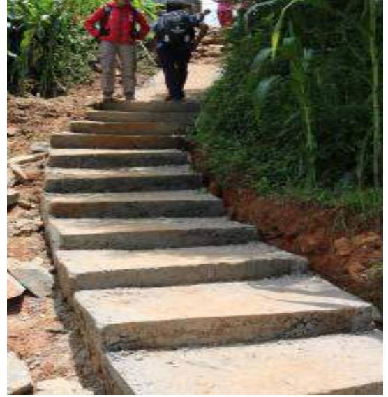
पदमार्ग निर्माण-गण्डकी गाउँपालिका, गोरखा
