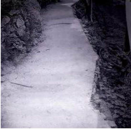
सडक निर्माण-तिलागुफा नगरपालिका, कालिकोट
