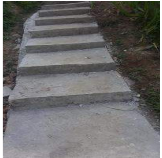
पैदल मार्ग निर्माण-गण्डकी गाउँपालिका, गोरखा
