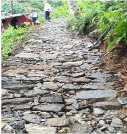
गोरेटो बाटो निर्माण-महालक्ष्मी नगरपालिका, धनकुटा
