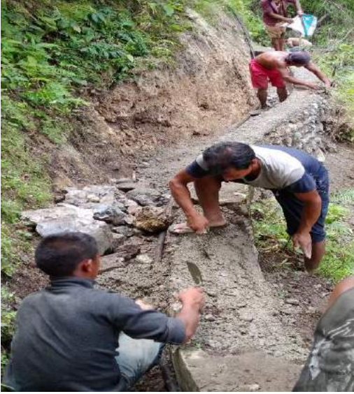
सिचाई कुलो मर्मत-देवघाट गाउँपालिका-१, तनहुँ
