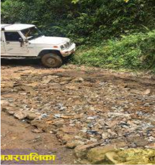
कुलो निर्माण तथा बाटो मर्मत-भीरकोट नगरपालिका-६, स्याङ्जा
