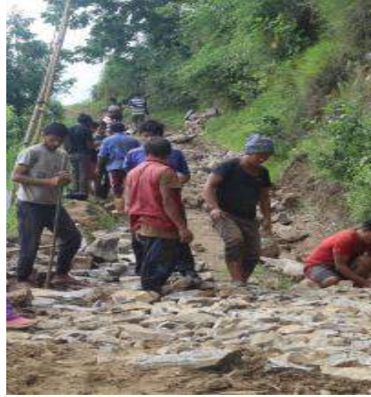
सडक निर्माण-फालेलुङ गाउँपालिका, पाँचथर
