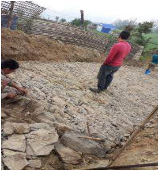
सडक मर्मत-ऐसेलुखर्क गाउँपालिका, खोटाङ
