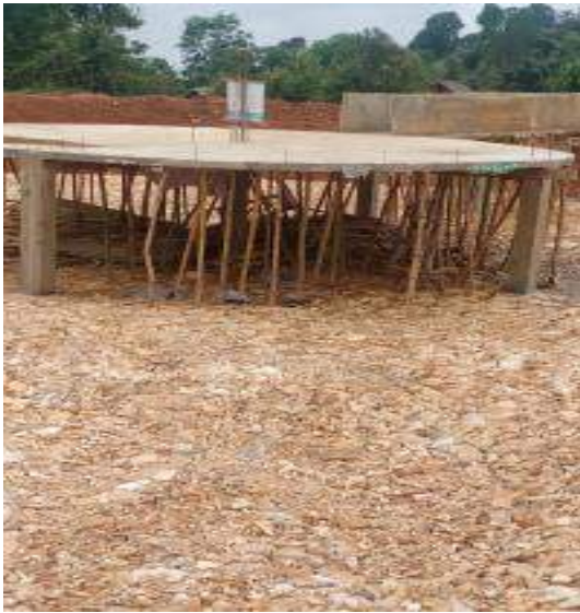
बहुउद्देश्यीय सिचाई पोखरी निर्माण-माडी गाउँपालिका-५, रोल्पा
