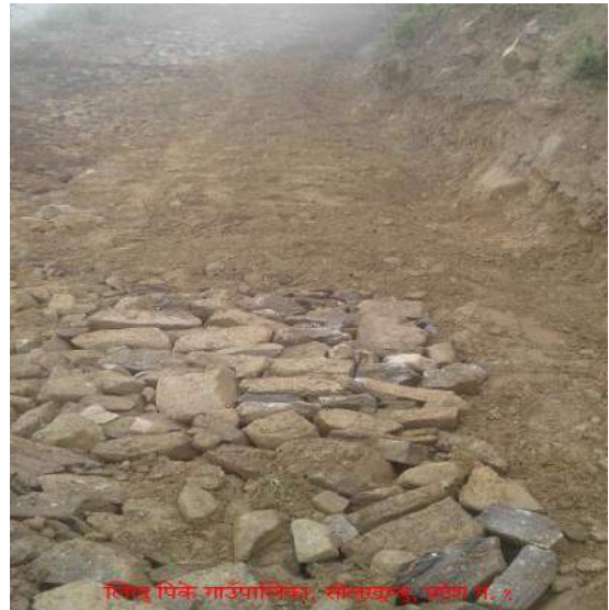
सडक सोलिड-लिखु पिके गाउँपालिका-५, सोलुखुम्बु
