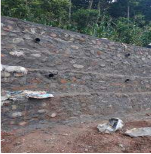
सिचाई निर्माण-लिखु गाउँपालिका-५, नुवाकोट
