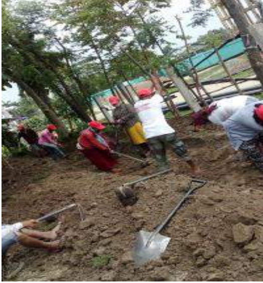
खानेपानी पाइप लाइन विस्तार-रामधुनी नगरपालिका, सुनसरी
