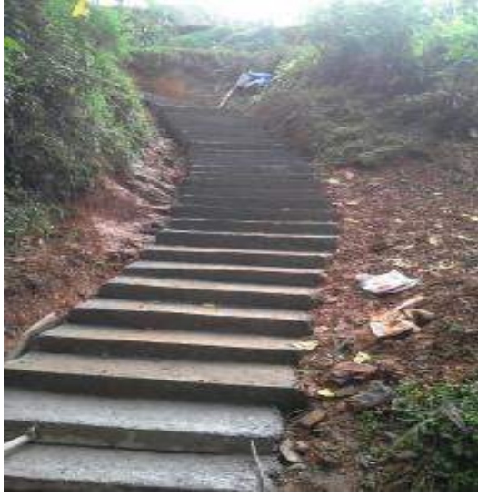
सिढी निर्माण-जैमिनी नगरपालिका, बागलुङ
