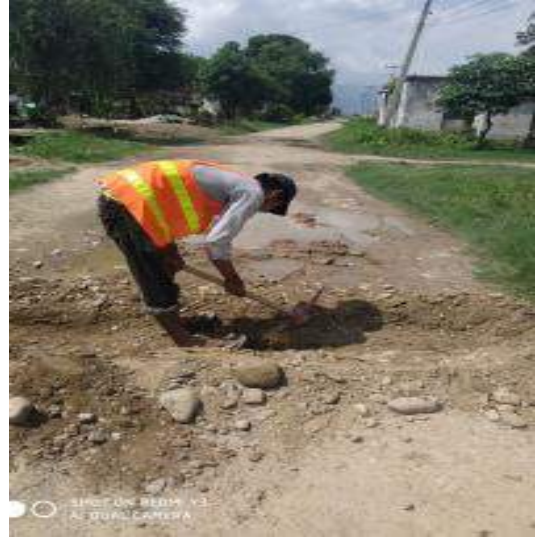
जिर्ण सडक मर्मत-तिलोत्तमा नगरपालिका-१२, रुपन्देही
