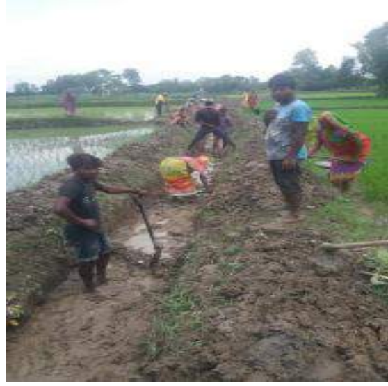
सरसफाई र पैनी निर्माण-विष्णुपुर गाउँपालिका, सिराहा
