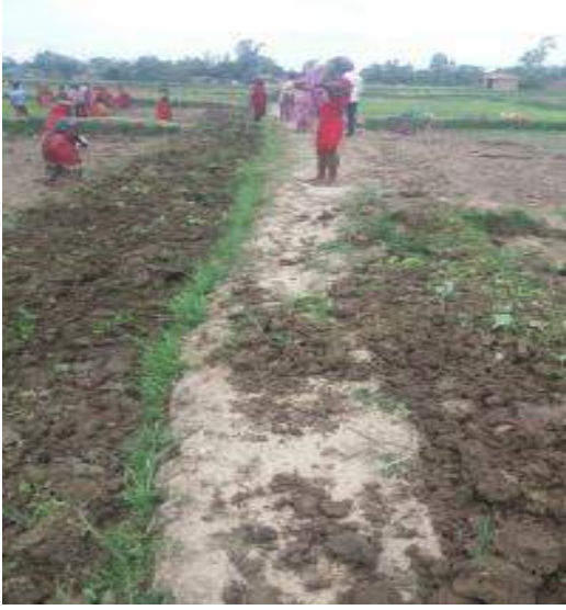
नयाँ कृषि सडक निर्माण-विष्णुपुर गाउँपालिका, सिराहा
