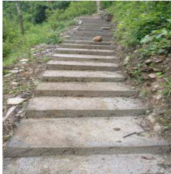
पैदल मार्ग निर्माण-गण्डकी गाउँपालिका, गोरखा
