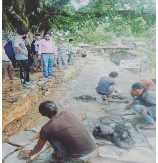
पदमार्ग निर्माण-देवघाट गाउँपालिका-४, तनहुँ
