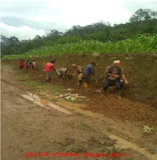
कुलो तथा नाली निर्माण-लिखु पिके गाउँपालिका-३, सोलुखुम्बु
