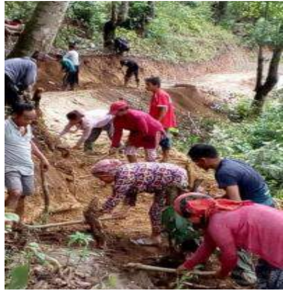
सडक स्तरोन्नती-छथर जोरपाटी गाउँपालिका-१, धनकुटा
