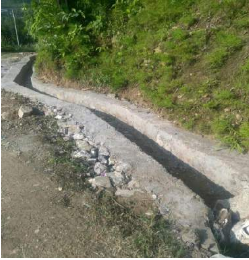
कुलो निर्माण-सुनकोशी गाउँपालिका-३, सिन्धुपाल्चोक
