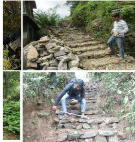
पद मार्ग निर्माण - मेलम्ची नगरपालिका-४, सिन्धुपाल्चोक
